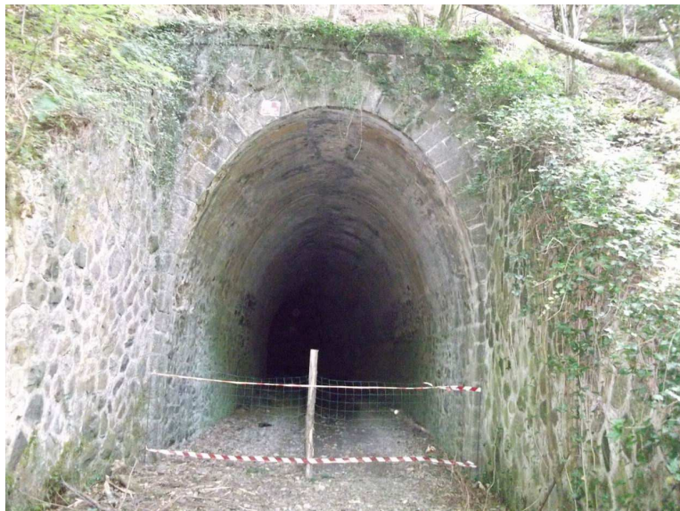
entrée avec grillage du tunnel de Galizan [photo UTT Lareure]
